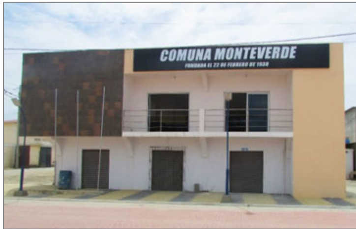
Vista frontal de la casa comunal de Monteverde
